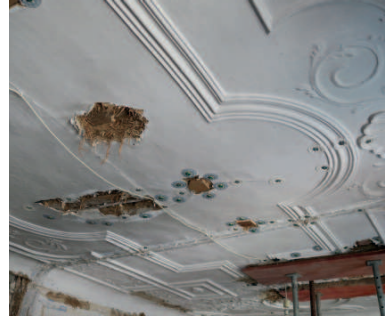
In Renovierung befindliche barocke Stuckdecke im Buchler-Palais
