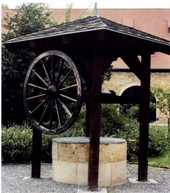
Ziehbrunnen, renoviert mit Brunnenschacht 25 m tief
