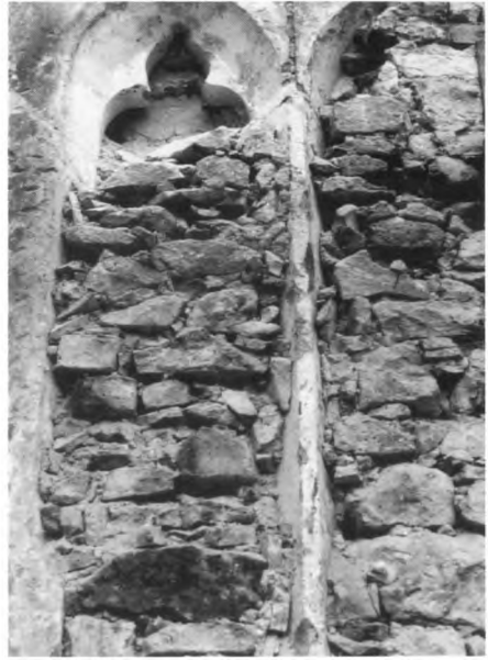
Abbildung 13: Ehemalige Kapellenfenster im alten Schaffnerhaus (Ostseite der Westwand) [A]
