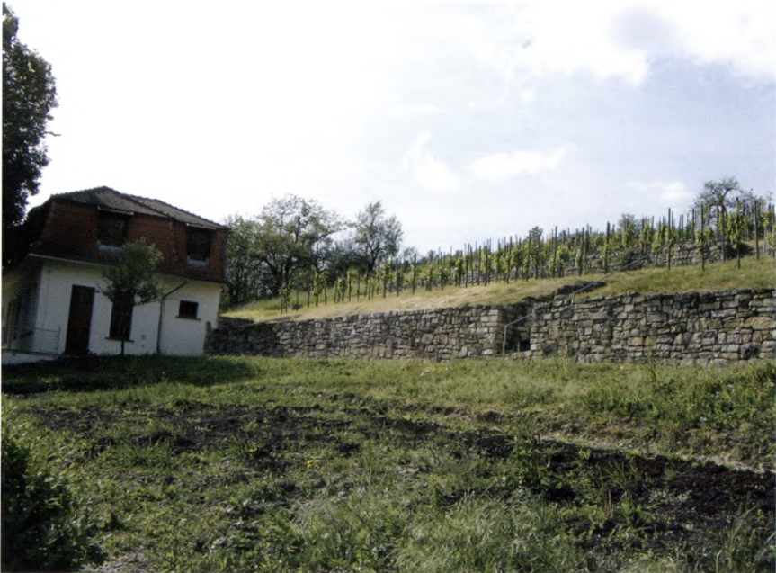
Abb. 13: Restaurierte Weinbergterrassen am Haus Lochfeld in Wittersheim
