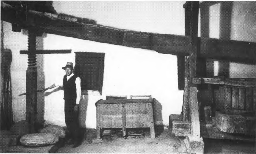
Abb. 8 Alte Baum-Kelter aus dem Jahre 1825 in der Weinbaugemeinde Bogeschdorf im Kleinkokler Weinbaugebiet. Die in das Kelter-Biet (rechts) eingefüllte Traubenmaische wurde mit dem großen Kelterbalken ausgepreßt, dessen Hebeleffekt durch eine mit Steinen beschwerte Spindelschraube (links) herbeigeführt wurde. – Manchmal waren auch Jahreszahl und Besitzer der Kelter sowie die Initialen des geschickten Zimmermanns, der die Baumkelter herstellte, in den großen Kelterbalken aus Eichenholz eingeschnitzt. (Foto: H. Rosdea-Weindel 1966).
