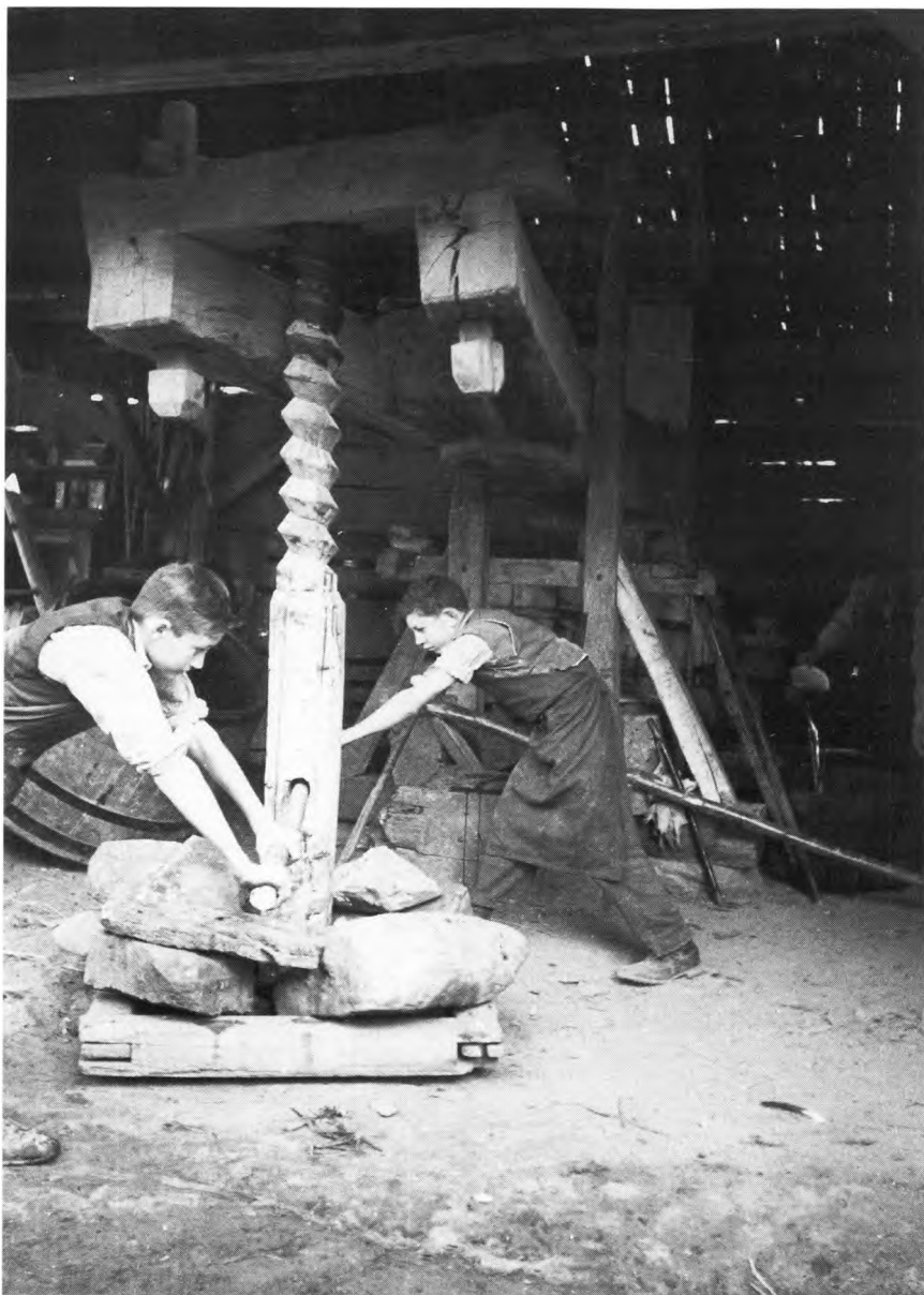
Abb. 7 Zwei Jungwinzer betätigen beim Auspressen der Maische die mit Steinen beschwerte Spindelschraube einer sehr alten Baum-Kelter in Birtzhälm. (Foto: A. Schotsch).
