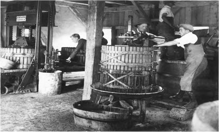
Abb. 9 Mechanische Spindelkelter und hydraulische Presse in Seiden, der bedeutendsten Weinbaugemeinde des Kleinkokler Weinbaugebietes. Sie haben um die Jahrhundertwende die große, alte Baumkelter abgelöst und durch ihre neue Technik ein zügigeres und auch besseres Auspressen der Maische ermöglicht. (Foto: Josef Fischer, um 1930).
